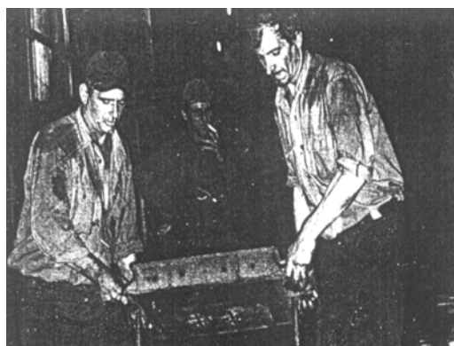
Slika 6. Prenošnje završnog kalupa na odlagalište gdje se vrši ljevanje.
