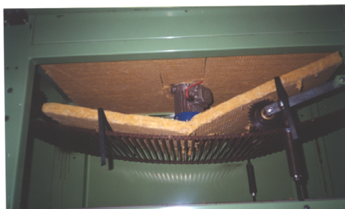
SLIKA 3: POSTUPAK UGRADNJE IZOLACIJONOG MATERIJALA (DVA SLOJA)
