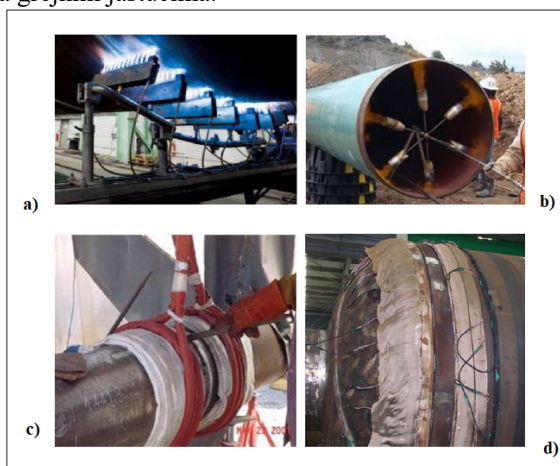
Slika 6. Predgrijavanje a) i b) sa gasnim gorionicima c) sa induktivnim grijačima d) sa elektrootpornim grijačima
