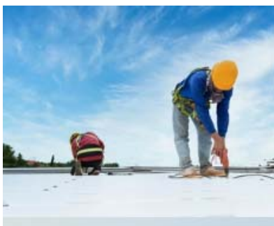
Slika 1. Rad na krovu
