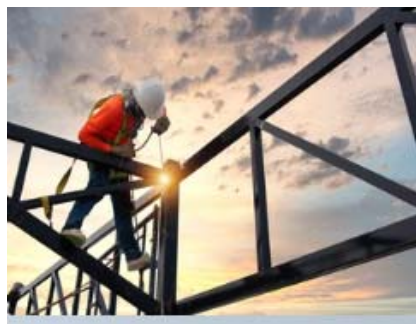
Slika 2. Rad na konstrukciji
